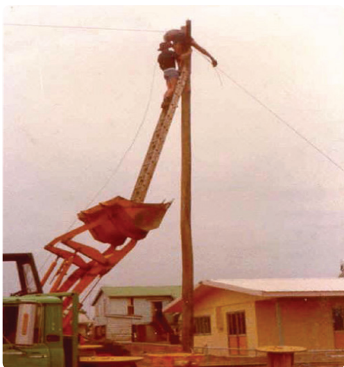
عدم رعایت ایمنی در برق‌رسانی کارگاهی و بالا رفتن از نردبان
